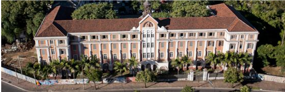
Figura 1: Fachada frontal(oeste) do edifício
